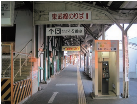
資料12 連続立体交差化事業による高架化工事実施直前の伊勢崎駅(旧JR線1番線側から資料13の方向へ向けて撮影)。JR線と東武線の改札内乗換が可能であったが、IC乗車券で東武線を利用する場合は、IC乗車券中間改札機にタッチする必要があった。
