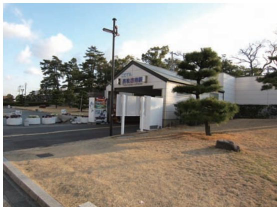
資料21 高松琴平電鉄高松築港駅。JR高松駅へは、信号機のある中央通りを横断し、さらに資料20の駅前広場を通り抜けなければならない、徒歩5分程度を要する。
