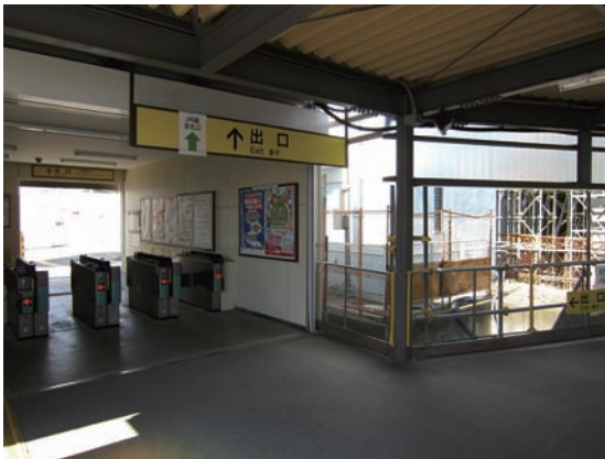
資料13 連続立体交差化事業による高架化工事進行中の伊勢崎駅。JR線と東武線の改札は分離され、改札外での乗換を強いられることとなった(改札分離前は、自動改札機右側の柵の先から資料12のJR側へつながっていた)。
