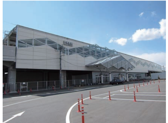
資料14 連続立体交差化事業による高架化工事進行中の伊勢崎駅。JR線側駅舎はほぼ完成している
