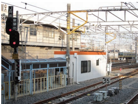
資料4 東京地下鉄東西線西船橋駅構内に設置されているJR総武本線および東葉高速鉄道線への出発信号機。東西線・東葉高速鉄道線直通列車は終日運転されるが、東西線・総武本線との直通列車は朝夕に限られる
