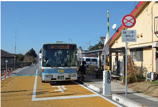
(写真3 四箇村駅バス専用道出入口②)
