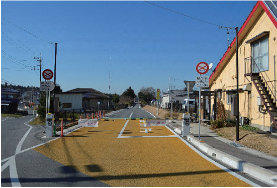
(写真2 四箇村駅バス専用道出入口①)
